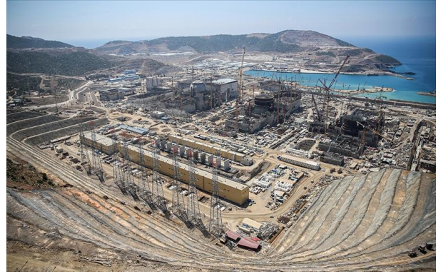
Şekil 7 Akkuyu NGS İnşaat Sahası (Fotoğraf: Anonim)
