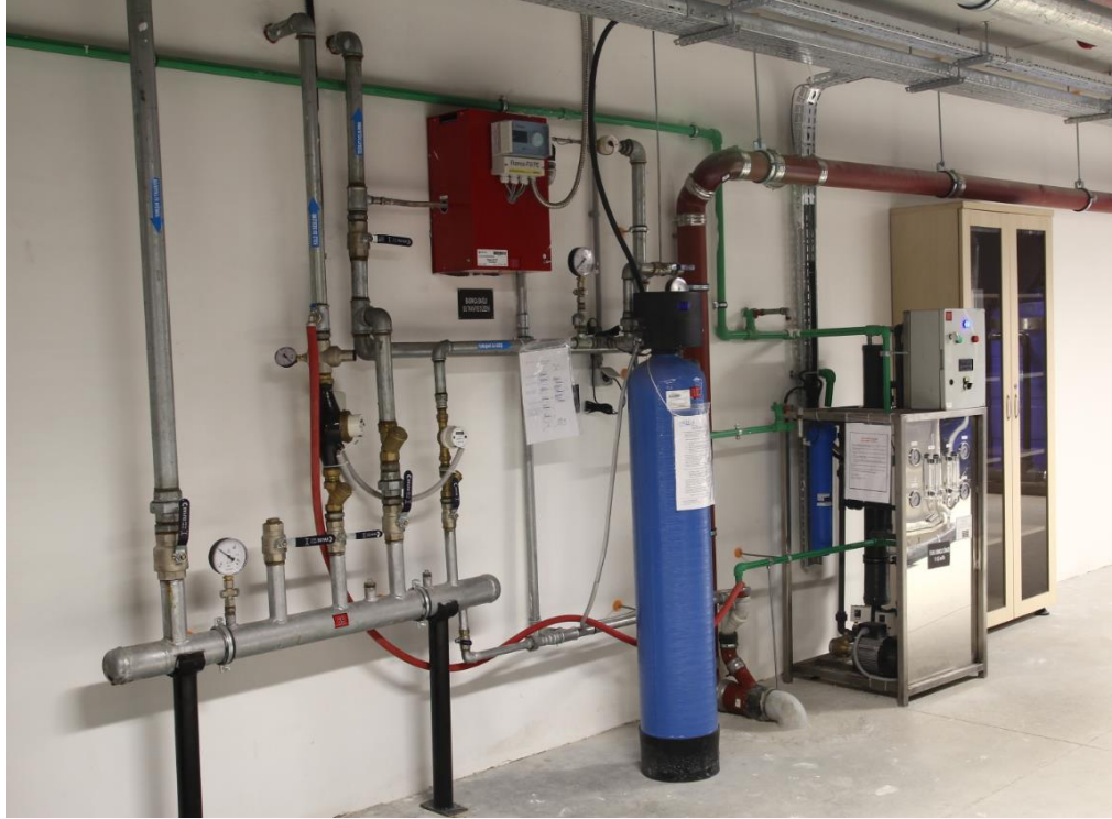
Tesisat merkezi : içme suyu sistemi.
