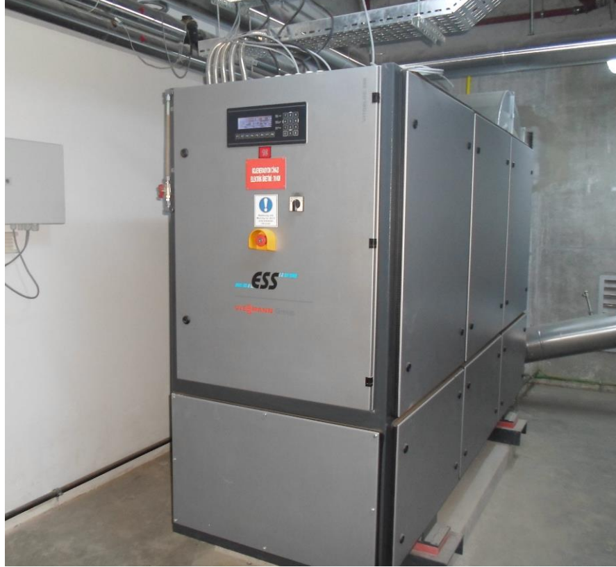
Tesisat merkezi : Paket tip kocenerasyon cihazı.
