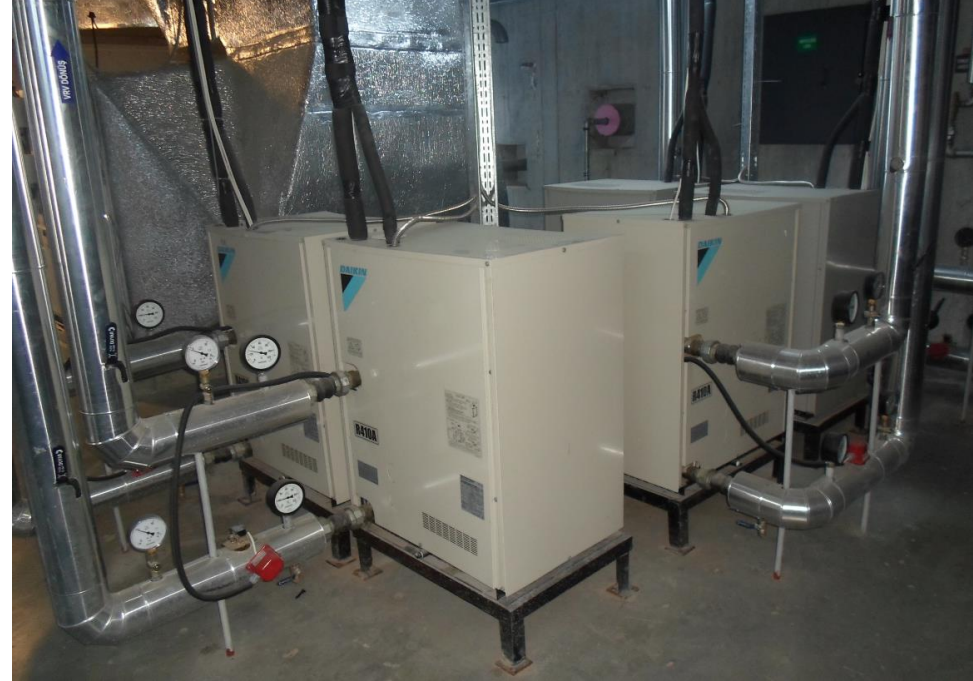
Tesisat merkezi : Su kaynaklı ısı pompası (sulu VRF).
