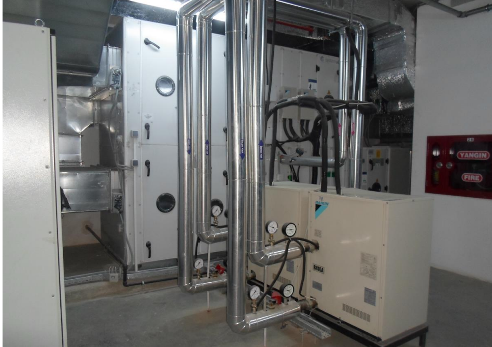
Tesisat merkezi : Su kaynaklı ısı pompası (sulu VRF).
