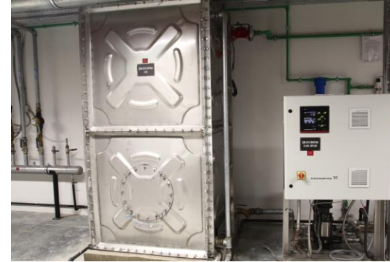
Tesisat merkezi : içme suyu sistemi.
