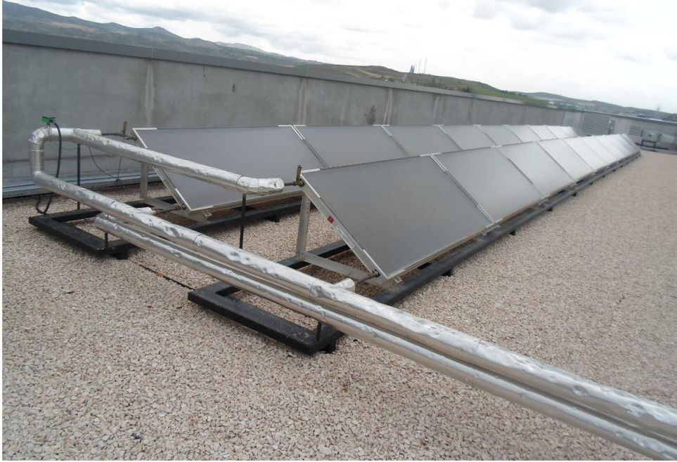
Güneş sıcak su kolektörleri.
