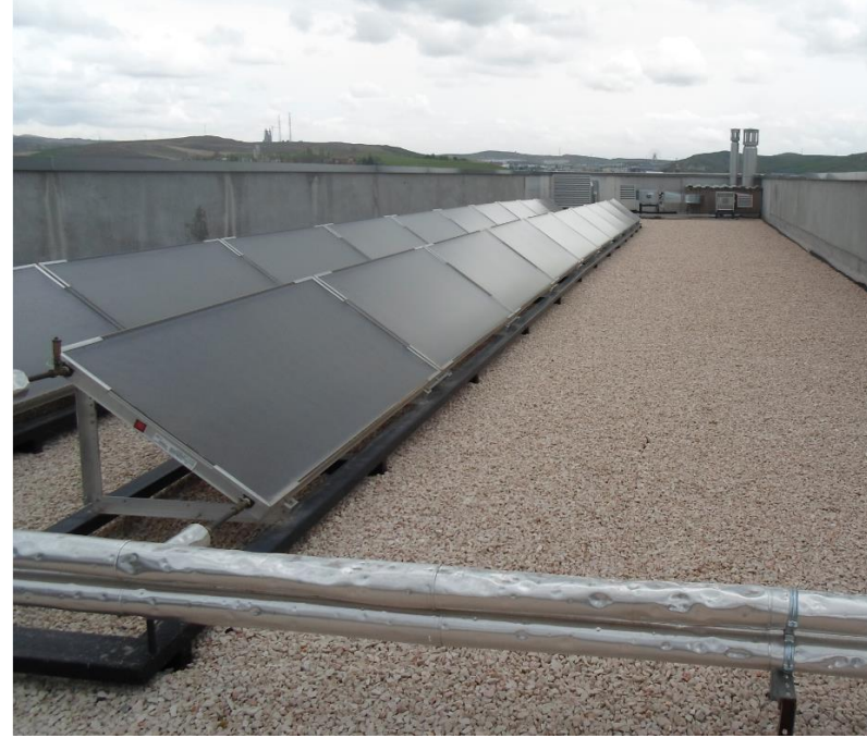
Güneş sıcak su kolektörleri.
