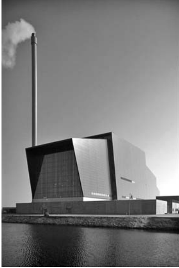
Şekil 11. Danimarka'da, 2003'de bölgesel ısıtma yapmak üzere kurulan bir çöp yakma santrali [11].
